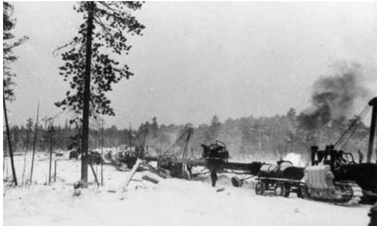
На строительстве нефтепровода Усть-Балык - Омск, важнейшей стройки Среднего Приобья, 1965 г.
